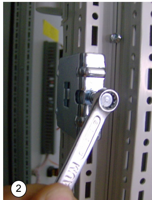
Монтаж стягивающего соединителя на вертикальных профилях шкафа
