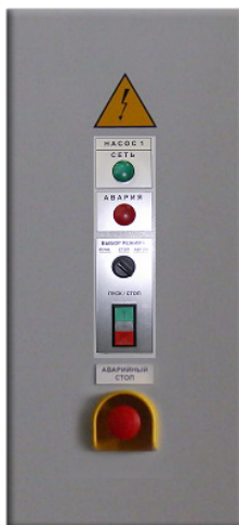
Рис. 4. Выносной пульт ручного управления насосом.
