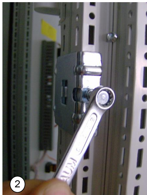
Монтаж стягивающего соединителя на вертикальных профилях шкафа
